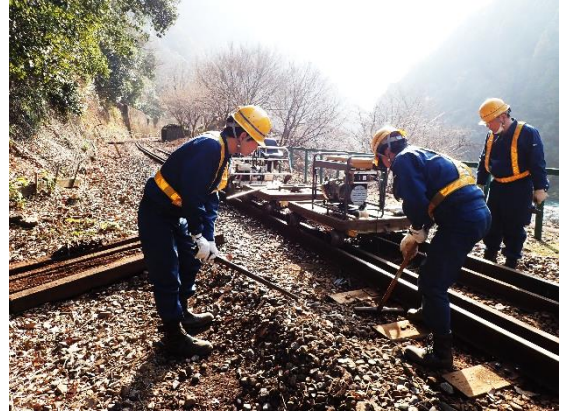
【技術継承を目的とした直轄作業によるマクラギ交換作業】
