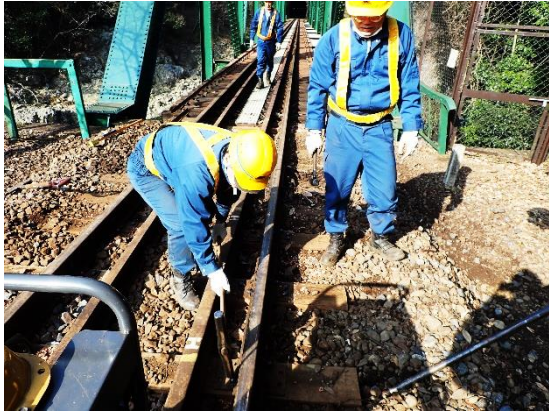
【技術継承を目的とした直轄作業によるマクラギ交換作業】
