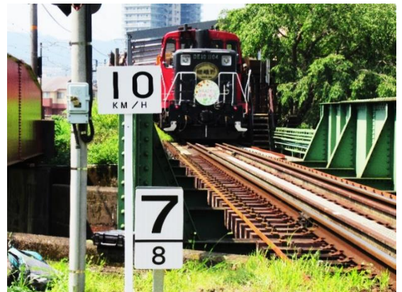
【劣化により視認性が低下した運転諸標の取替え】
