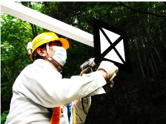
【劣化により視認性が低下した運転諸標の取替え】
